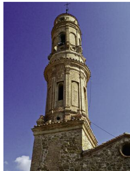
❖ Torre-campanario de la iglesia
