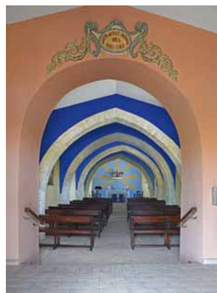
Interior de la ermita de San Miguel, con cuatro arcos fajones y el del antiguo pórtico de medio punto.
