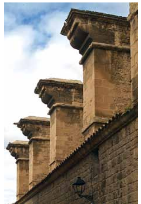
Contrafuertes laterales rematados por modillones.
