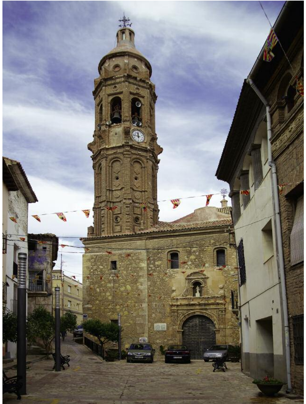
❖ Vista exterior de la iglesia desde la plaza
