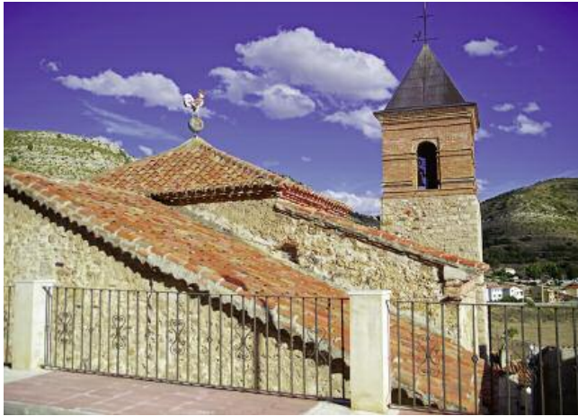
❖ Vista exterior de los pies de la iglesia desde calle elevada
