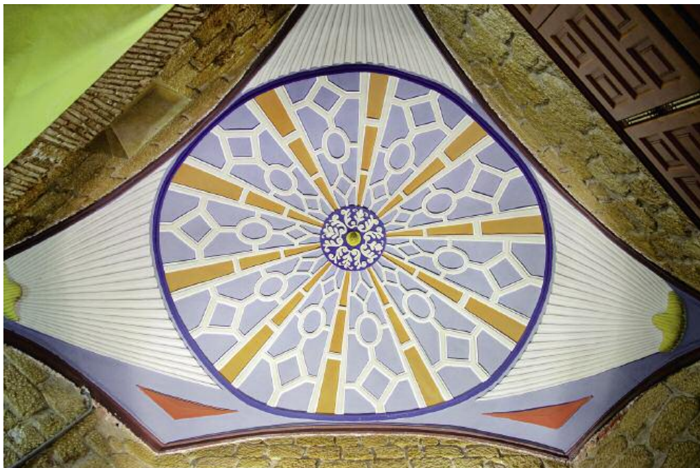
❖ Bóveda de la sacristía de la iglesia
