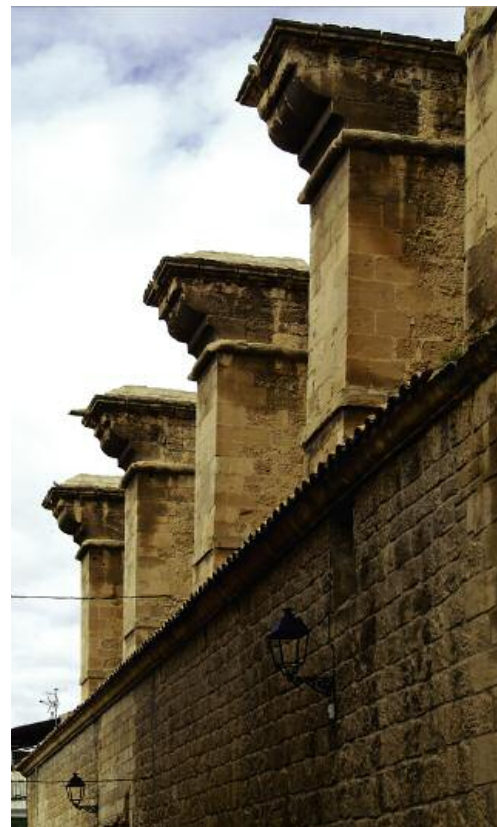
❖ Contrafuertes de la iglesia
