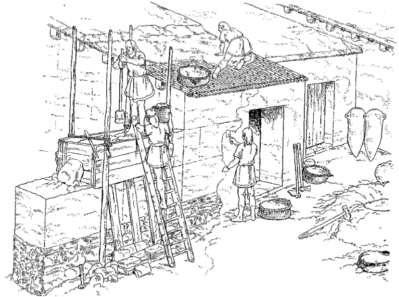
Construcción de tapial. Dibujo F. Riart.
