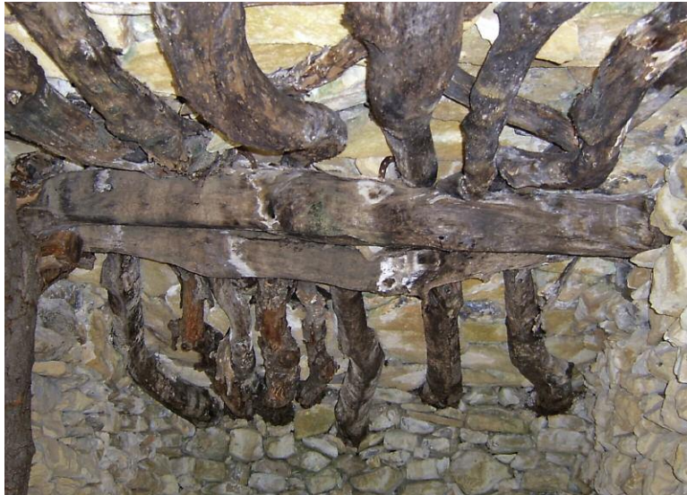
Detalle de la cubierta de una caseta tradicional.
