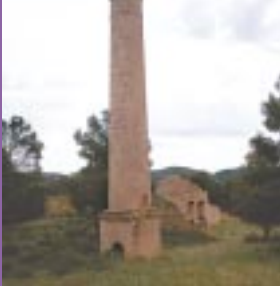
Chimenea de la resinera que hubo en el paraje conocido como La Codoñera.
