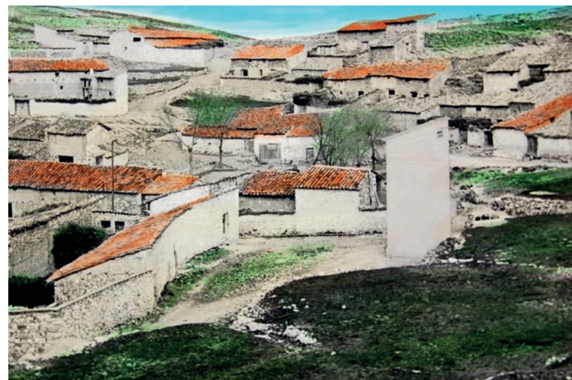
Vistas desde el pozo de las Eras, c. 70. Se observa en primer término a la derecha el edificio donde se cobija el transformador de la luz. Postal Exclusivas Modesto Serrano coloreada a mano (pertenece a la colección Ballester Pascual).
