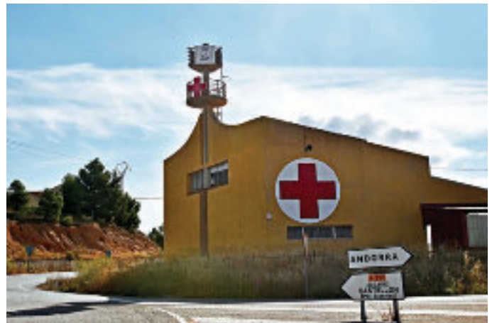
Edificio de la Cruz Roja desde la carretera de entrada a Andorra.
