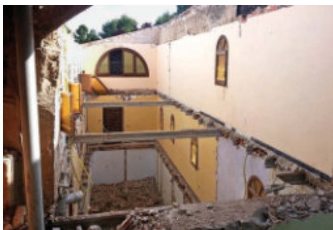
Trabajos en los muros y vaciado del edificio para su restauración.
