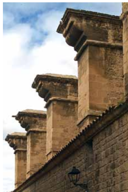
Contrafuertes laterales rematados por modillones.
