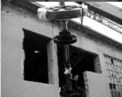
Trabajos encaminados a posicionar el eje motriz de la máquina.
