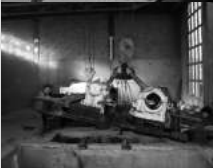
Una instantánea de las maniobras efectuadas para colocar bancada.
