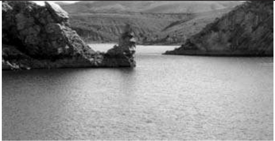
El embalse de Cueva Foradada fue construido hace 100 años, entre Alcaine y Oliete, para abastecimiento y riego. La huerta de Alcaine fue la gran perdedora, las aguas la cubrieron.
