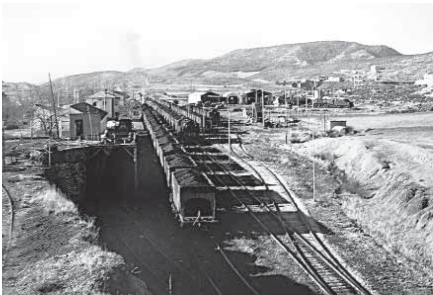
Vista de conjunto de las instalaciones en la estación de Andorra en 1982
