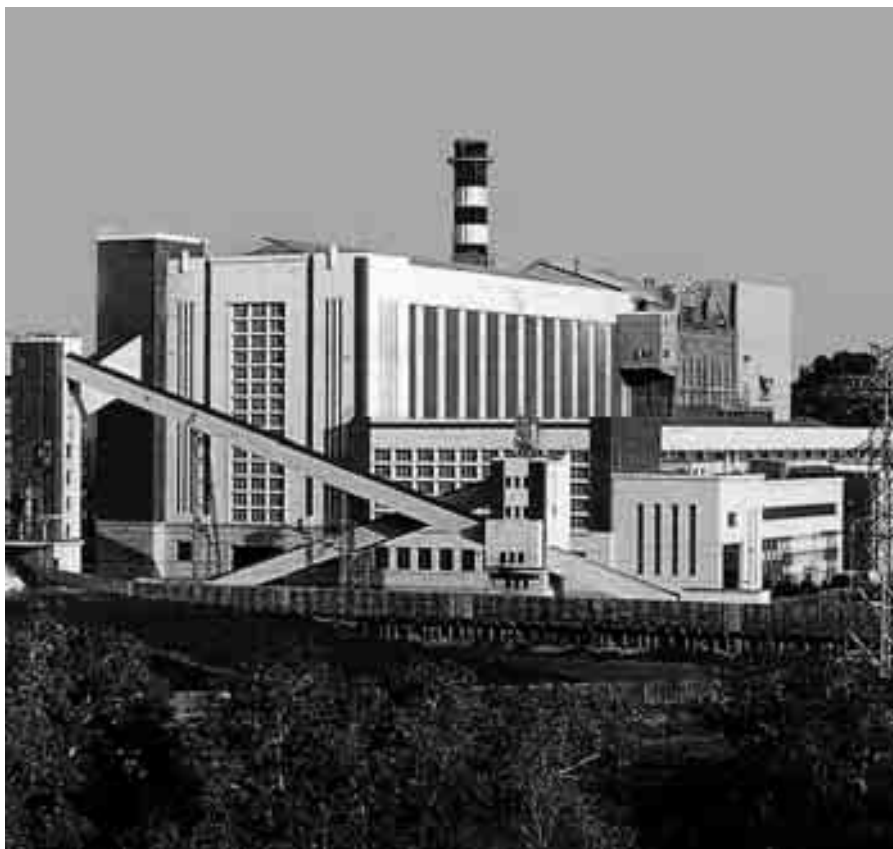
Instantánea de la Central de Escatrón en los años setenta, única instalación fabril que sobrevivió a los planes iniciales de ENCASO.
