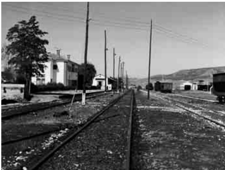
Estación de ferrocarril construida en Andorra, de donde se transportaba el lignito extraído en la cuenca hasta Escatrón.
